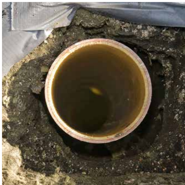
Dešťový svod po sanaci
