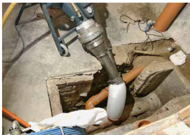
Sanační zařízení pro opravu domovních přípojek
