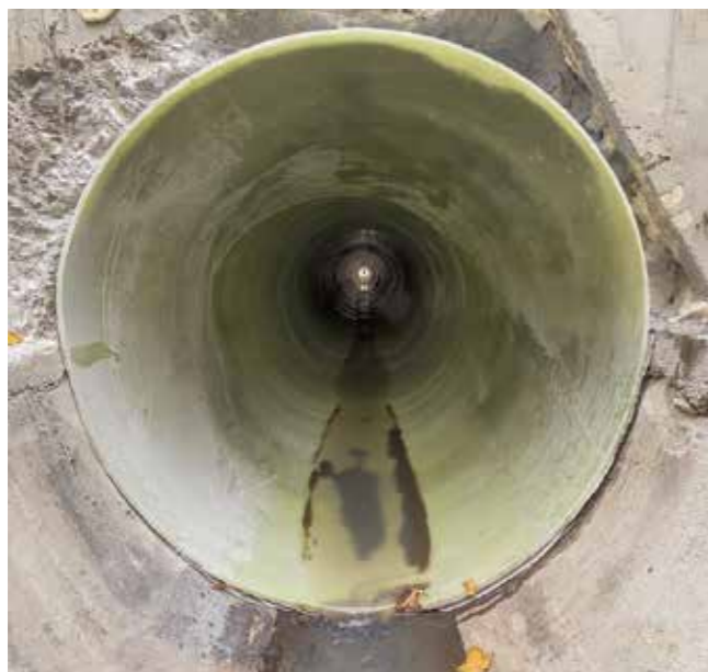
Kanalizační potrubí po sanaci
