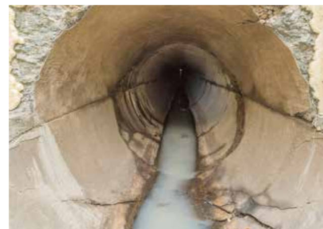
Kanalizační potrubí před sanací
