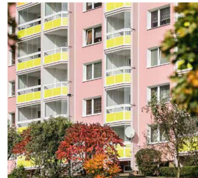
Prodloužení lodžii, ul. Brněnská, Česká Lípa, realizace r. 2017
