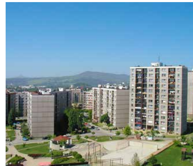
Sídliště Špičák v České Lípě, r. 2001 před začátkem éry zateplování panelových domů
