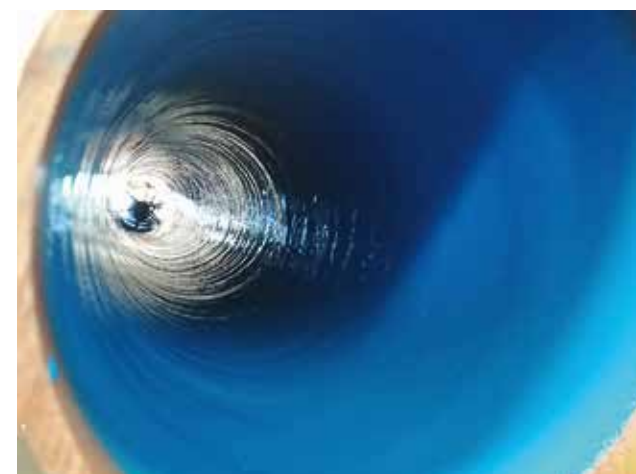
Po vyčištění vytvoříme uvnitř nástřikem úplně nové potrubí
