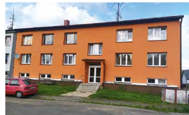
Lesná u Tachova – 5 bytových domů – dodávka tepla z tepelných čerpadel nahradila dosluhující obecní kotelnu
